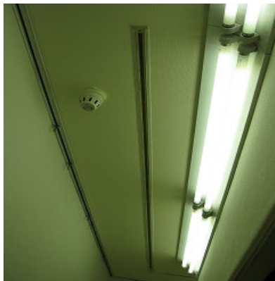
展示ケース内上部 ピクチャーレール・照明・スポットライト用レール
